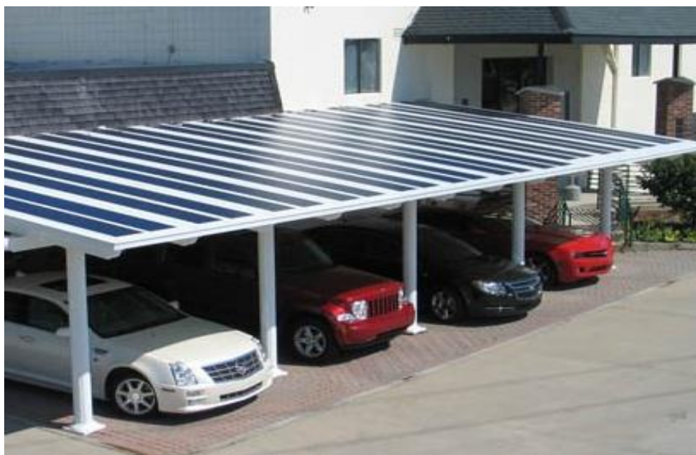
Рис. 4. Автостоянка с энергетическим навесом
