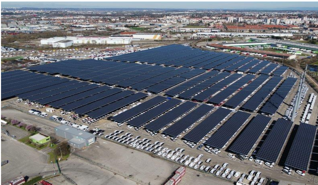
Рис.6. Автостоянка с энергетическими навесами в г. Корбас
